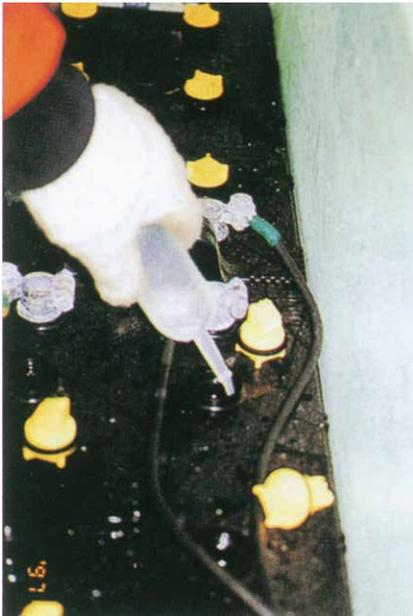
蒸留水補給作業
