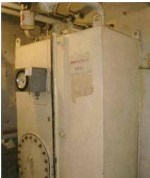
燃料がオーバーフロー→直下の主機関排気管の熱源で引火
